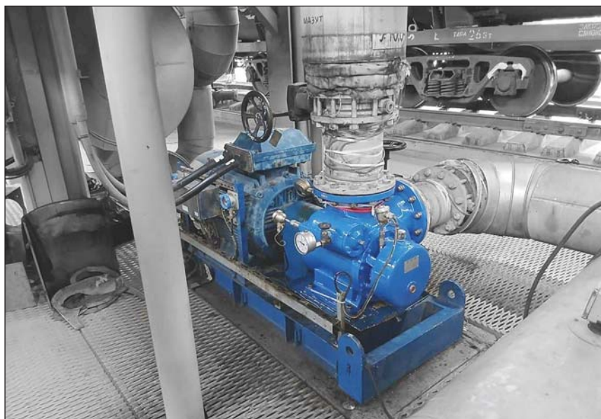
Рис. 32. Замена винтового насоса
