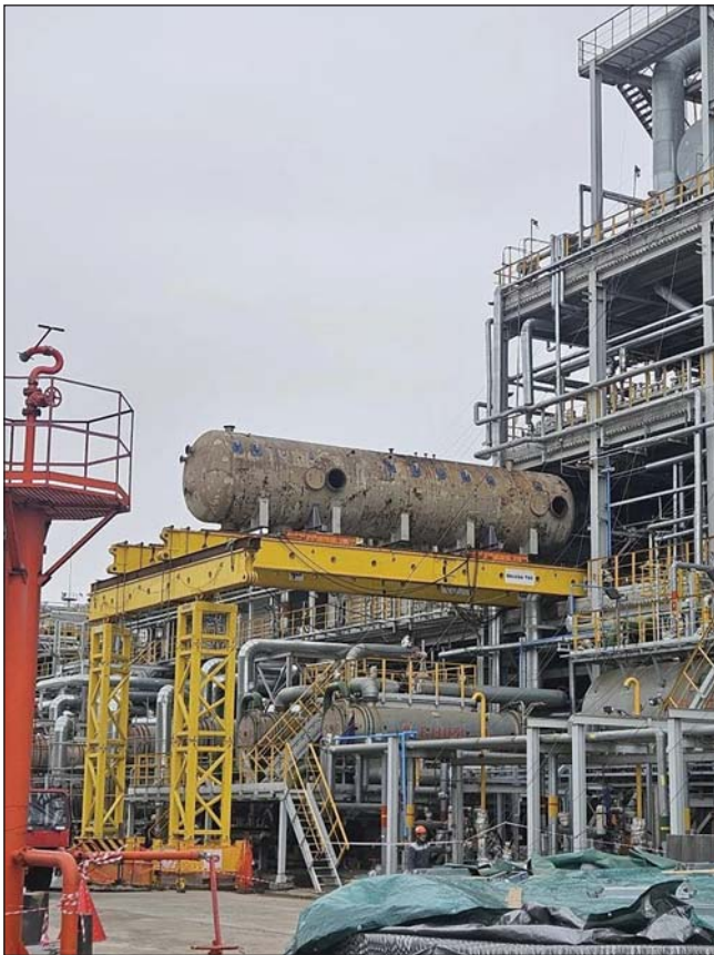
Рис. 1. Замена сепаратора
